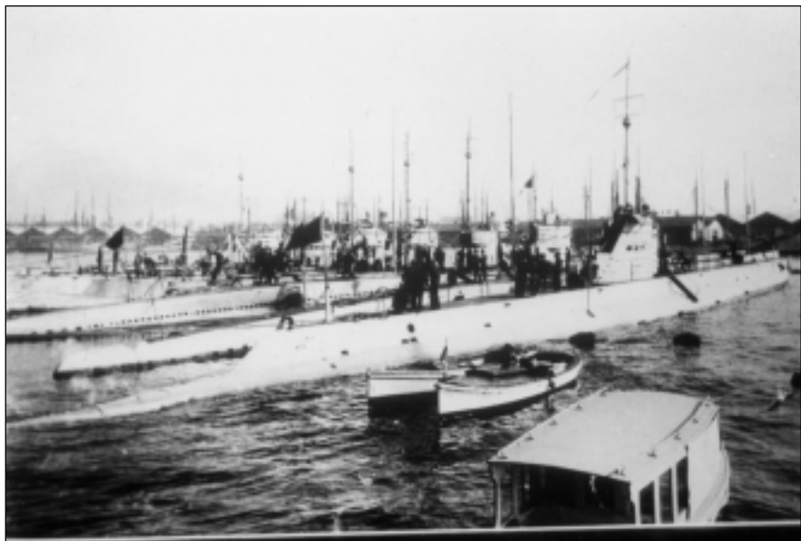
Foto arch.: J. Montoro Fort.
